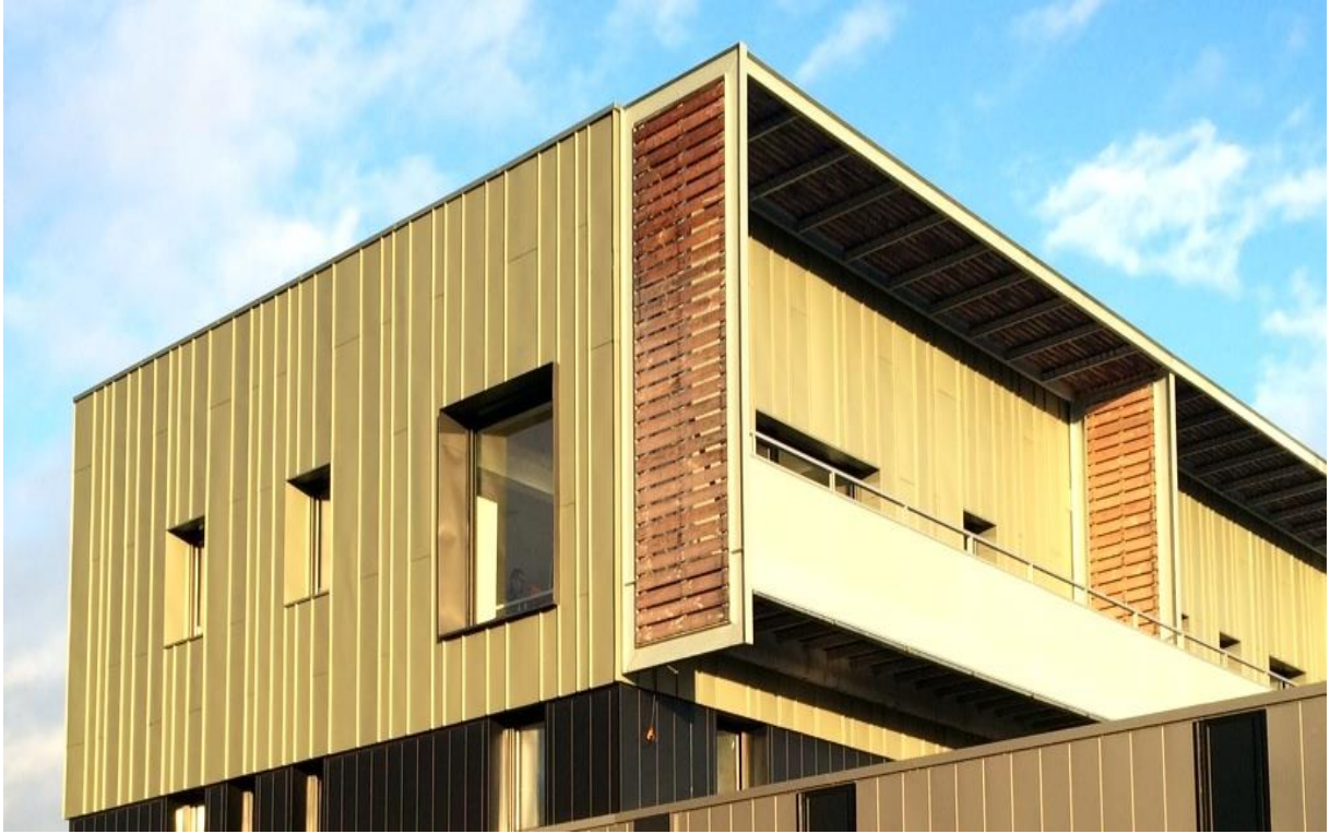
Locaux de l'architecte Geoffroy Sétan Paray le Monial : construction BBC avec double flux.
